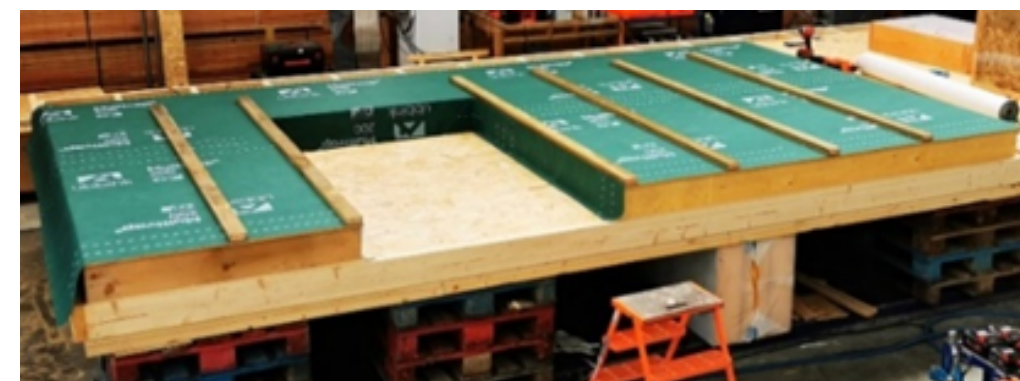
Caisson de toiture
