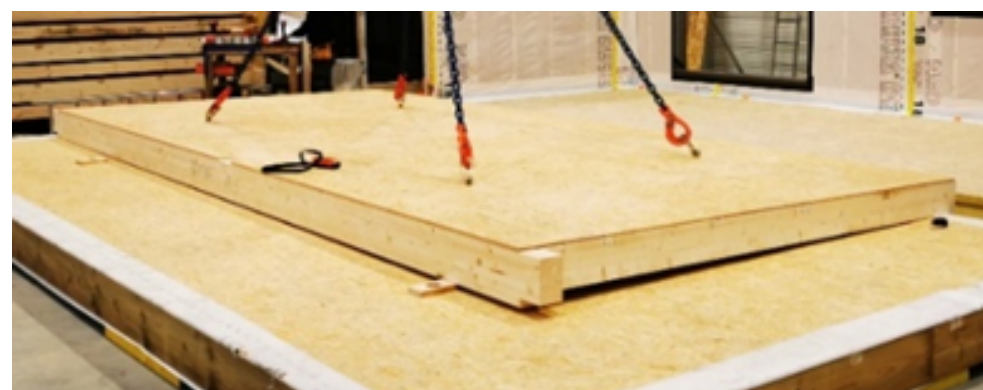
Caisson de plancher
